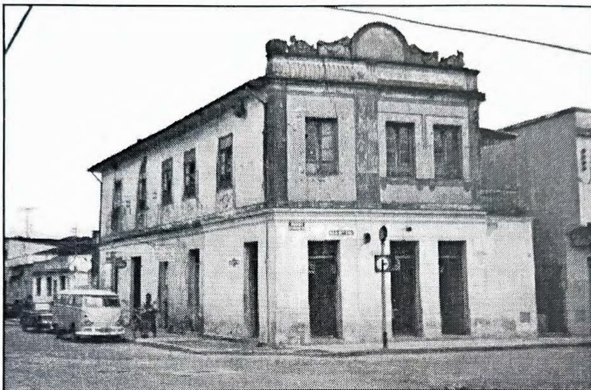
VELHA CASA JÁ DEMOLIDA - Existiu no bairro urbano da Avenida, em frente à padaria Soberana, ora também demolida. Fotografia de 1983, feita por Vigorelli.
