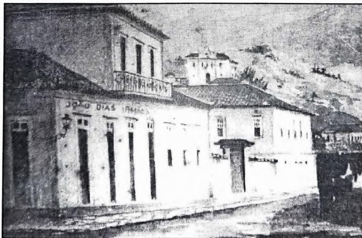
ARMAZÉM DA FIRMA JOÃO DIAS & IRMÃOS, na Rua
