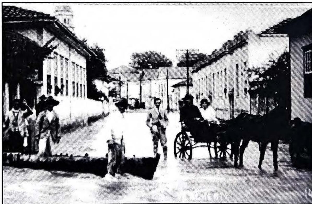
RUA XAVIER LISBOA EM DIA DE ENCHENTE - Vê-se, à esquerda, a residência do Cap. João José Rennó, falecido em 1925,
